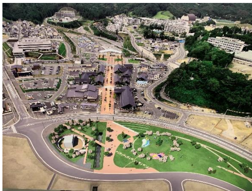
2020年9月ごろ完成する女川町海岸広場
