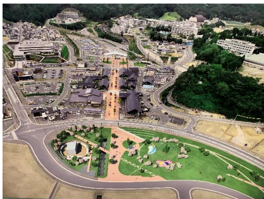
2020年9月ごろ完成する女川町海岸広場
