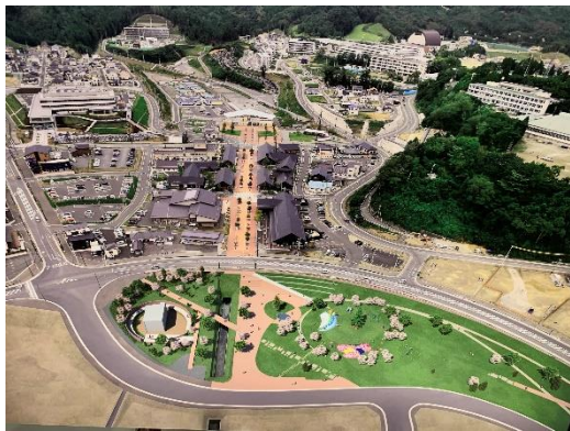
2020年9月ごろ完成する女川町海岸広場
